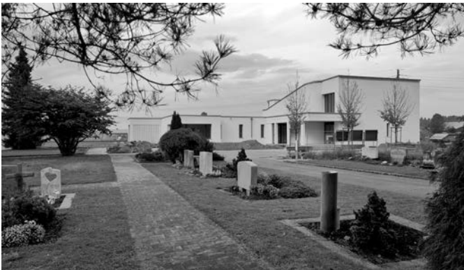
Endspurt für die Sanierung des Gebäudes.
